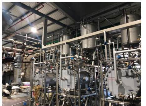
23/24/25 製程區之 4 樓配管與線槽施作
