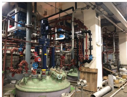
23/24/25 製程區之 2 樓配管施作現況
