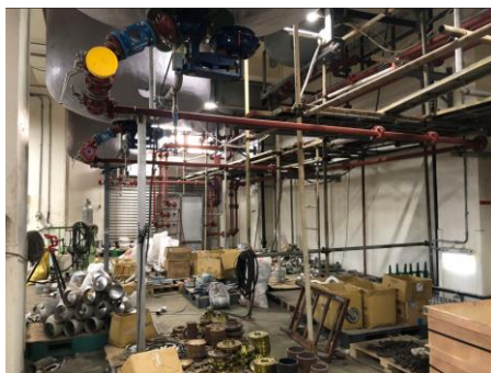
23/24/25 製程區之 1 樓配管施作現況
