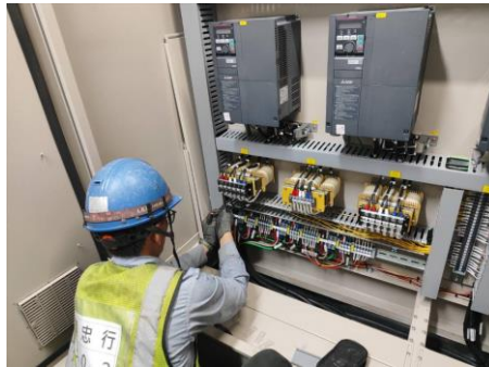
21 製程區之製程桶槽動力盤配線查核
