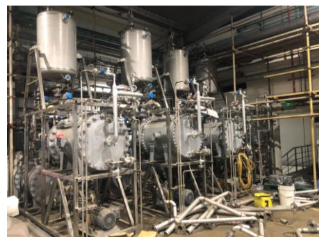
23/24/25 製程區之 4 樓配管施作現況
