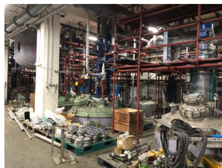
23/24/25 製程區之 2 樓配管施作現況
