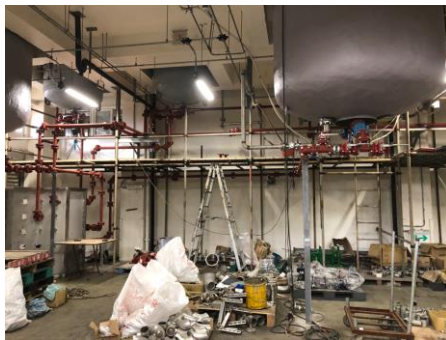
23/24/25 製程區之 1 樓配管施作現況
