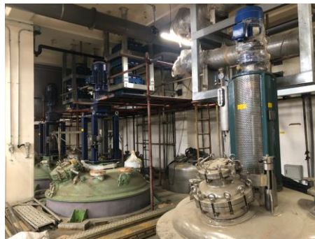
23/24/25 製程區之 2 樓配管前置準備
