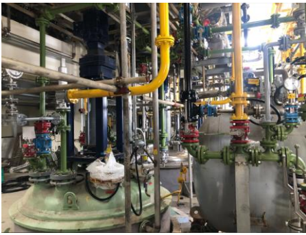
21 製程區之儀電接線施作現況
