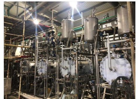
23/24/25 製程區之熱交換器配管施作
