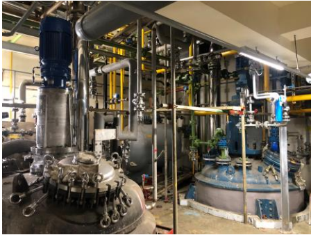
21 製程區之製程配管施作現況
