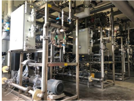
21 製程區之熱交換器儀電配線施作
