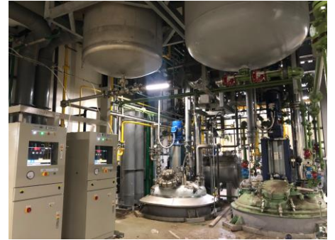
22A 製程區之製程桶槽試車前置測試中
