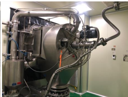
22A 製程區之離心機建置工程現況
