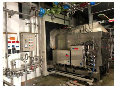
22A 製程區之離心機儀電配線施作
