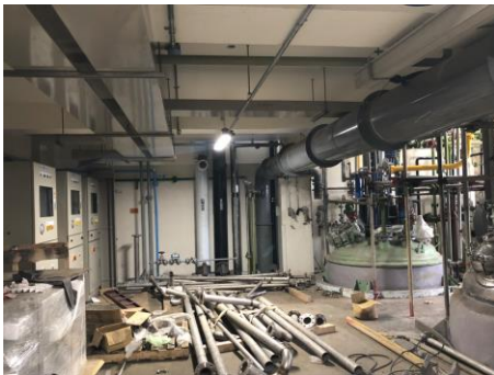
21 製程區之製程配管施作與控制盤一隅
