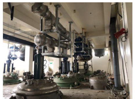
23/24/25 製程區之設備吊裝定位現況
