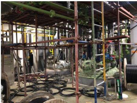
22A 製程區之製程桶槽儀電配線施作
