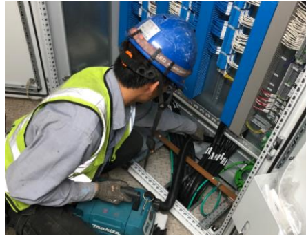
22B 製程區之離心機控制盤配線作業
