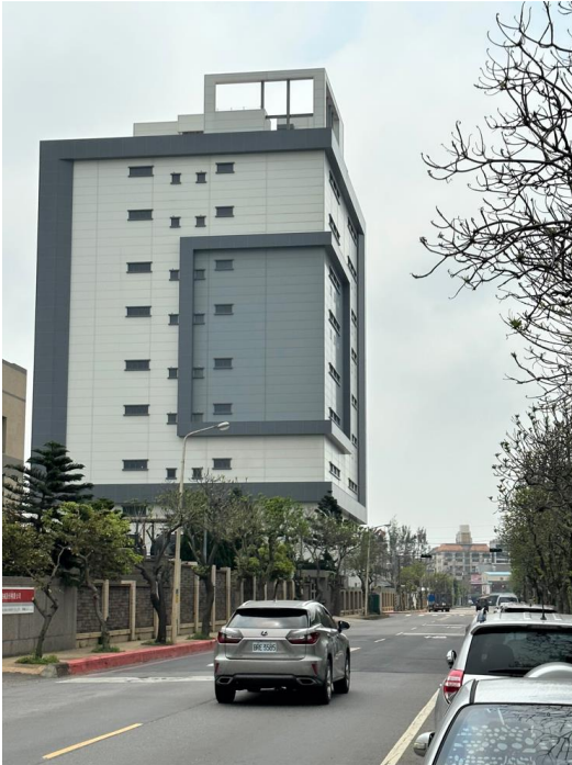
觀音廠建物外觀現狀
