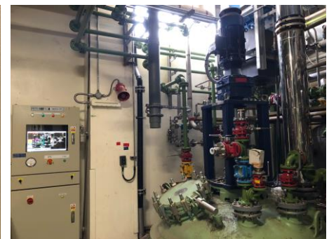
22B 製程區之製程設備試車作業中
