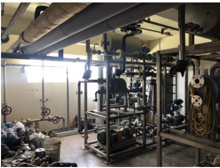
21 製程區之熱交換器配管施工中
