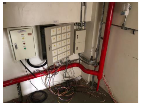
消防工程之控制電配線作業
