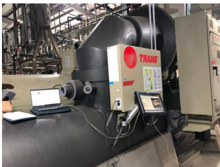
冰水主機之監控設備測試作業
