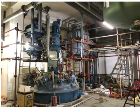
22A 製程區之 3 樓配管施工圖
