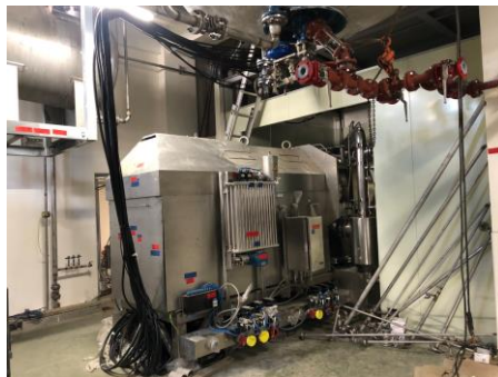
21 製程區之離心機儀控拉線施作
