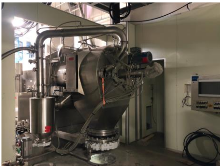
21 製程區之離心機安裝施工
