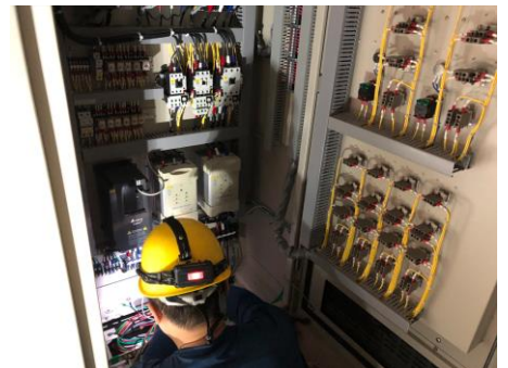
公共設施冰水系統之動力盤配線作業
