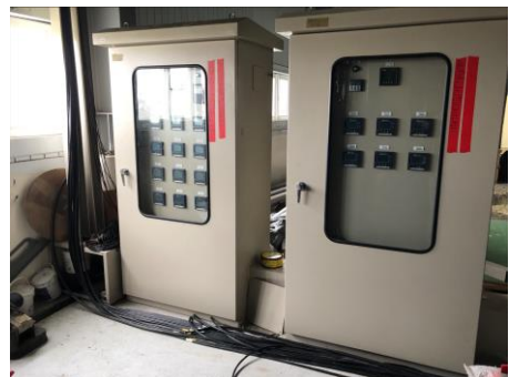
B 廠動力盤之拉線預置作業
