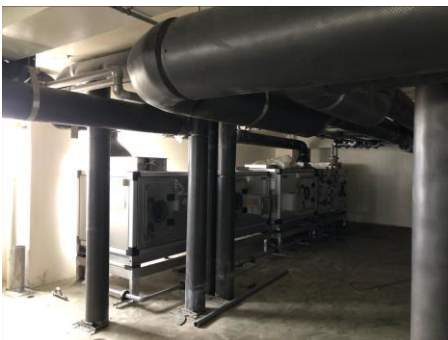
B 廠空調箱保溫作業
