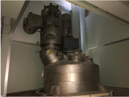
21 製程區乾燥機安裝作業
