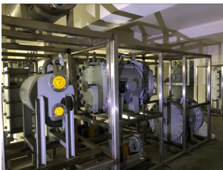
B 廠區熱交換器系統建置中
