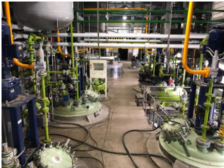
15 製程區第二階段設備驗證中
