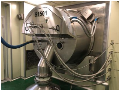
15 製程區離心機完成設備驗證
