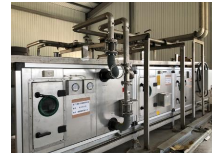
B 廠區空調系統 OAU 裝設中
