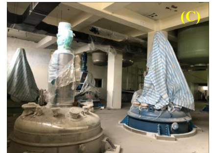
(C) 21/22 製程區桶槽完成定位一隅
