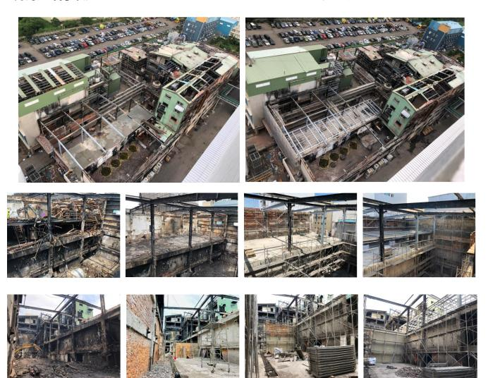
A廠區之原建物結構為RC鋼筋混凝土與鋼構平台所組成,故其建物修復工程目前主要施作為製程區之RC結構之模板組立及牆體混凝土澆置作業、純水製造區之鋼構平台建置,並逐步執行乾燥區之內部清運作業。其修復所需之鋼構組件之備料及預製作業,於日前已提早部署購置,以防缺料影響重建時程。因廠區原製程設備皆為半自動化操作生產系統,故除了現行之新購設備建置及公設修復工程,其RSView32圖控軟體系統亦同步與廠商研討建置作業,潔淨室及附屬設施之建置設計亦列入規劃安排作業中。
