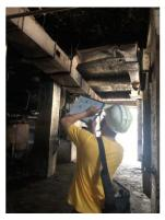
受損建築物之安全鑑定於日前已完成取樣作業,主要檢測項目為混凝土強度檢測、氯離子強度檢測、混凝土中性化深度檢測、垂直測量及燒失量等。取樣之樣品委由 TAF 認證實驗室執行檢驗,建築師依據國家標準 CNS1238 及 CNS3090 等基準規範,進行檢測數據之調查研
