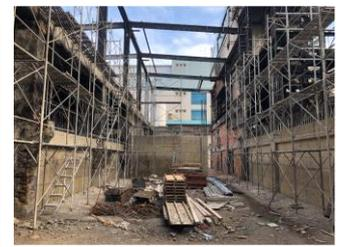
A 廠區第一階段重建正如火如荼展開中，其過程如圖所示，磚造牆/RC 混凝土牆補強作業、樓板防水工程及模板組立等，牆體混凝土澆置作業，部分鋼構主體因高溫變形，已替換取代，強化建物承重安全性。
