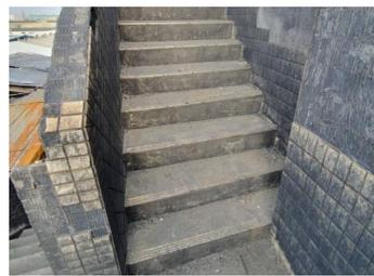
本周工作主要仍為持續執行清理作業，以利機器設備及生產廠房後續之查勘及鑑定，目前廠區電力供應已日漸完備，可讓行政辦公、檢驗分析及倉儲進出等日常例行作業無虞；但供應生產之變電站毀損，大火燒融之電源管線垂纏在建物內部，崩落的瓦礫及磁磚，在樓梯間形成了斜坡，模糊了階梯界線，阻擋了前進的腳步，在重機具無法進駐協助下，公設、生產及工務同仁們只能步履踉蹌一階一階往上人工清除，逐
