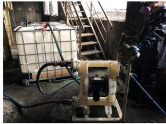
已完成初步清理作業廠區之生產設備的災損狀況，先由生產主管逐一查勘反應槽之槽體，因部分反應槽仍內含製程內容物，需先卸料才能確認反應槽的內襯狀況，依製程物的屬性、成份及體積量之彙整資料統籌卸料程序，若無法由桶底閥卸料，則以抽料管及動力機具執行，因產線內部電源線燒毀無法供電，故調度發電機，提供空壓機抽料之動力來源，並製作抽料管由人孔蓋開蓋抽料，以動力機具執行卸料作業前，生產同仁一再確認抽料管、化學軟管及空壓機間銜接安裝無虞，卸料裝桶之製程物皆以標籤明確標示品名。重建復原工作以安全為首要，主管再三叮囑務必留心每個作業環節，以達到零工安事故及零風險的最高指導原則，同仁們恪遵作業程序，為同一個目標拼搏努力，共同一條心分工合作，齊心協力完成任務，展現團隊默契與高度合作精神。
